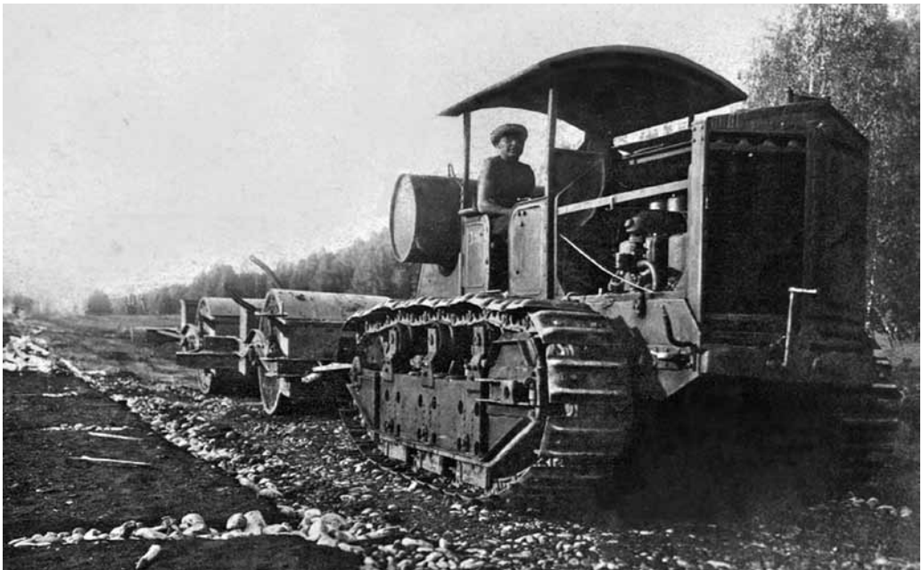
Укатка гравийной «одежды» полотна дороги
