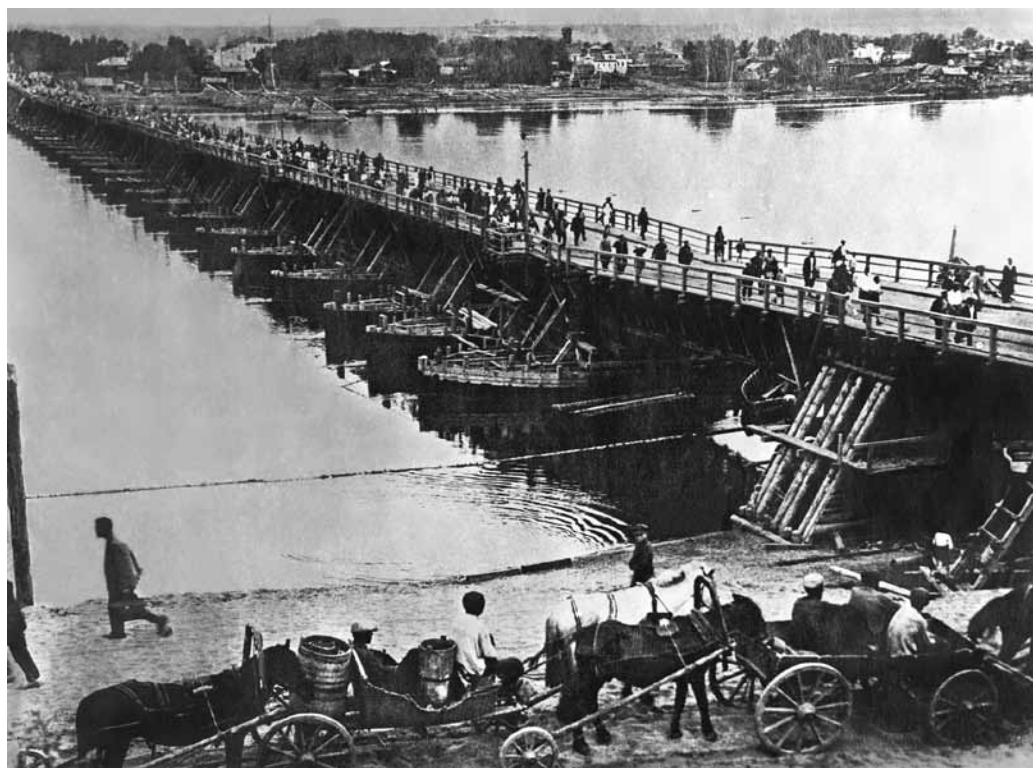
Понтонный мост через р. Бию построен в 1934 г.
