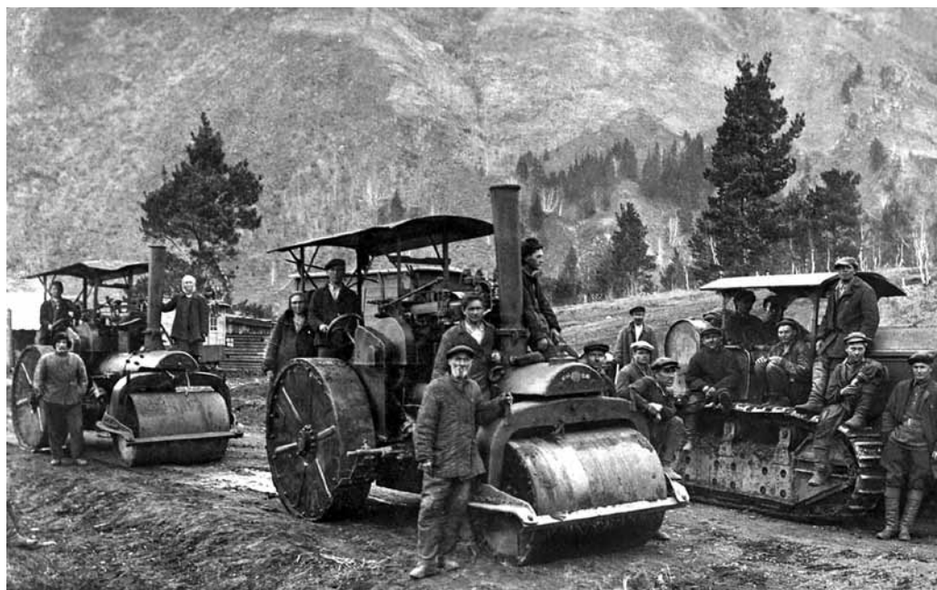
Строительные работы на Чуйском тракте в 30-е гг. XX в.
